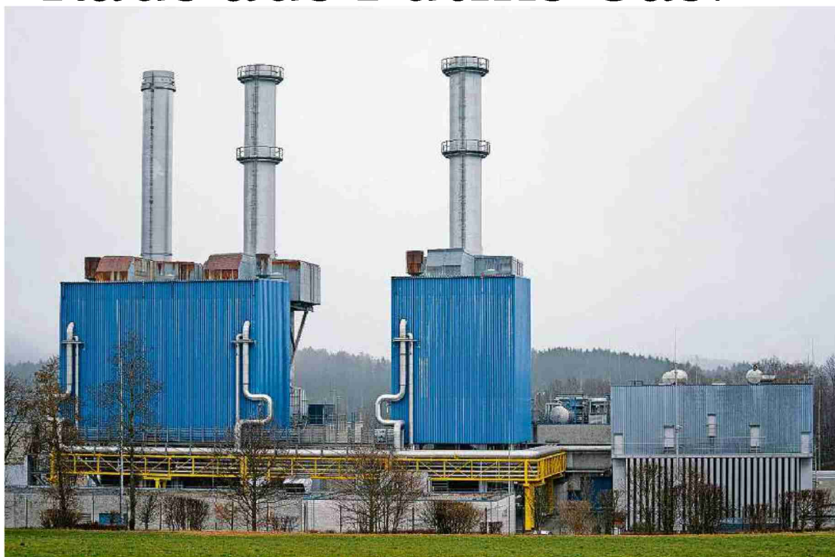
Graue Wolken ziehen über eine Erdgasverdichterstation in Deutschland. Die Verdichterstation in Mallnow nahe der deutsch-polnischen Grenze übernimmt vorwiegend russisches Erdgas . (FOTO KEYSTONE)
